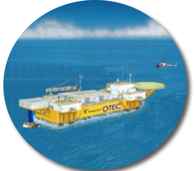
محطة أخرى طافية لإنتاج الكهرباء من مياه المحيطات
