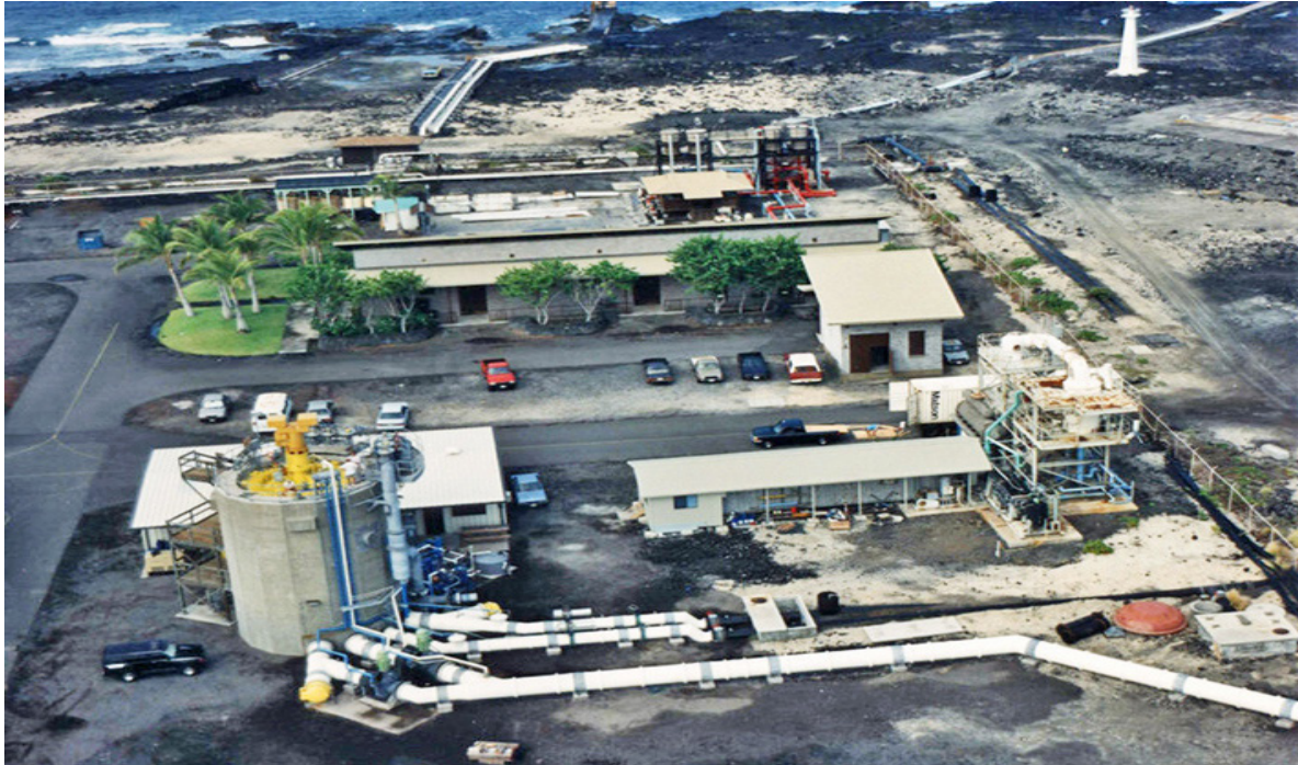
نموذج تجريبي لجهاز استخلاص حرارة المحيطات لشركة لوكهيد مارتن
