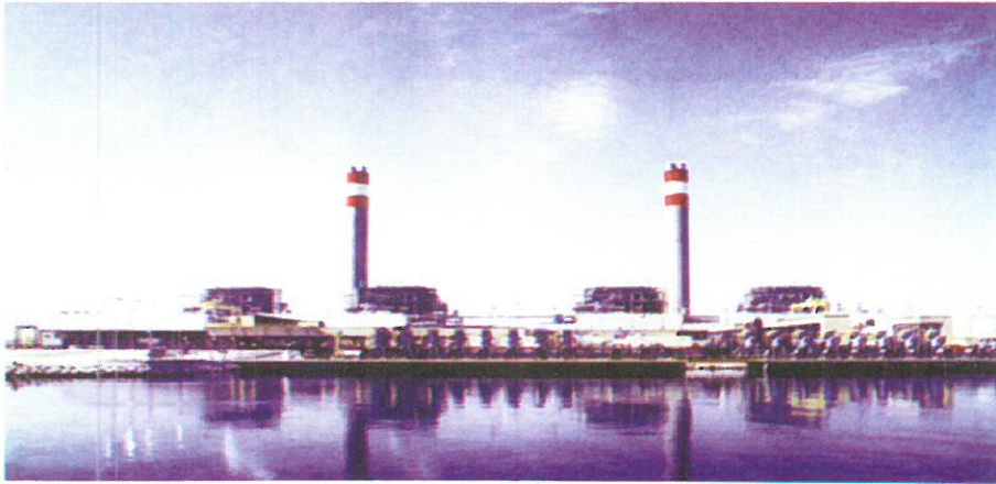
معمل لتحليه مياه البحر
