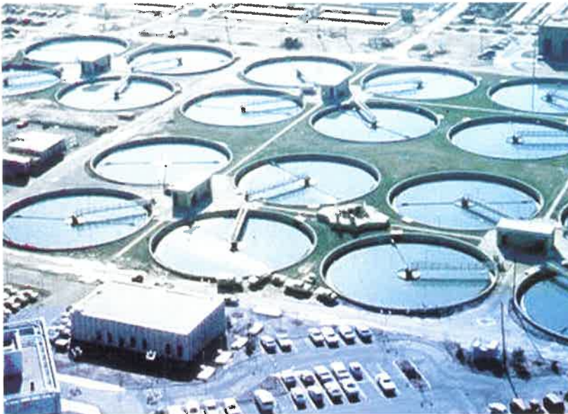
محطة تنقية مياه المجاري
